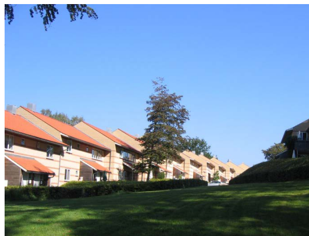
Etageboligerne på Gyvelholm er fra 1997. Bebyggelsen fremtræder i gule teglsten med vandrette røde murstensbånd og rødt tegltag.
