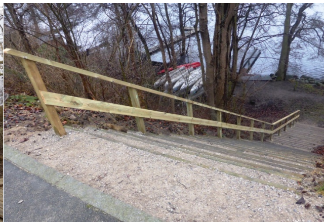
Renoveret trappe syd for regnvandsbassinet i Furesøparken
